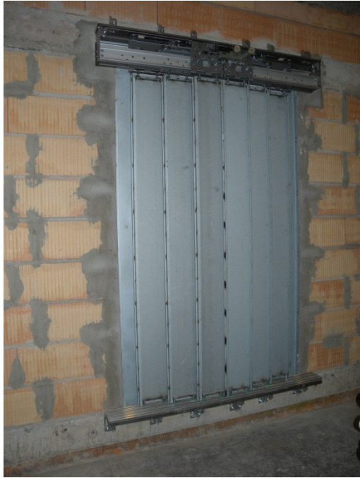
Bild 1: Ansicht einer Fahrschachttür (Schachtseite) im eingebauten Zustand.
